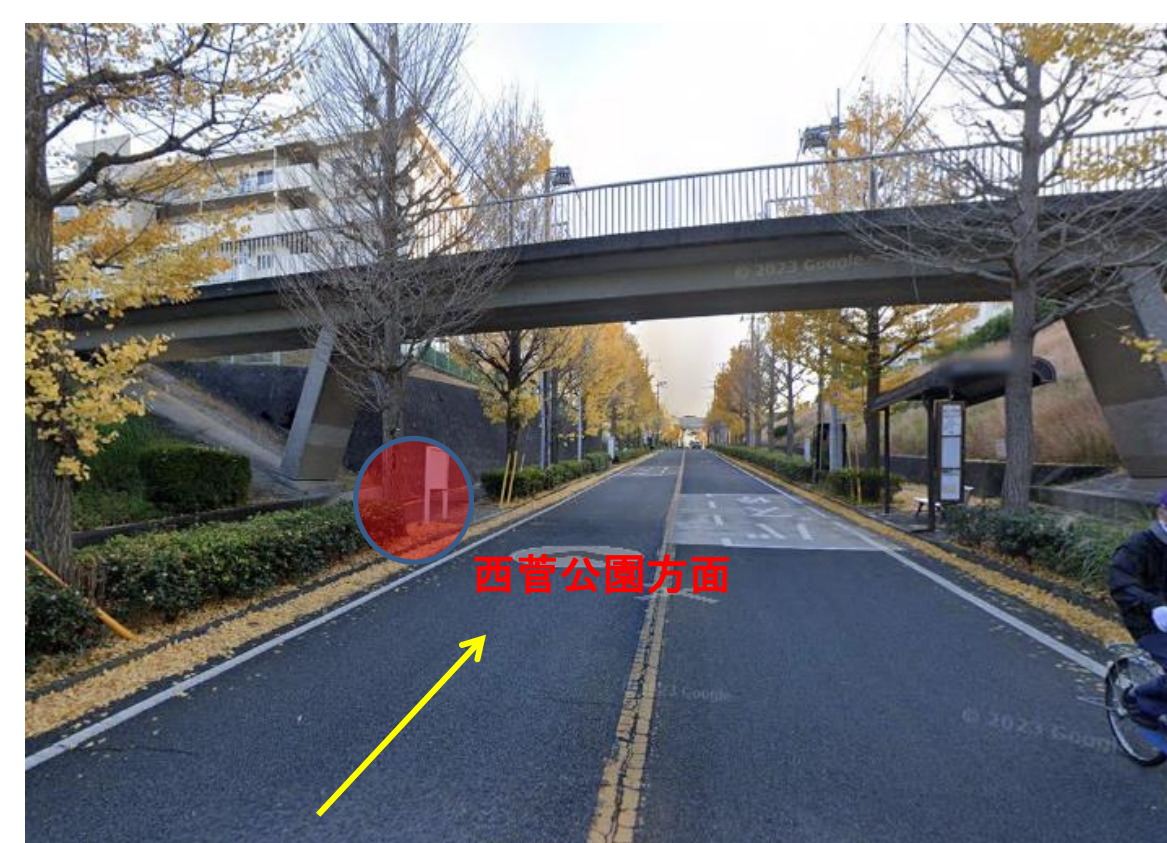
③星ヶ丘歩道橋 歩道橋の下
