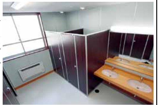
〔写真1〕 リニューアルした北棟のトイレ
